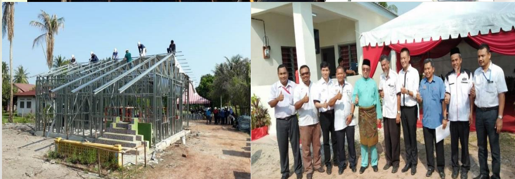
Proses pembinaan rumah termasuk aktiviti pengkonkritan dan pemasangan kerangka bumbung
