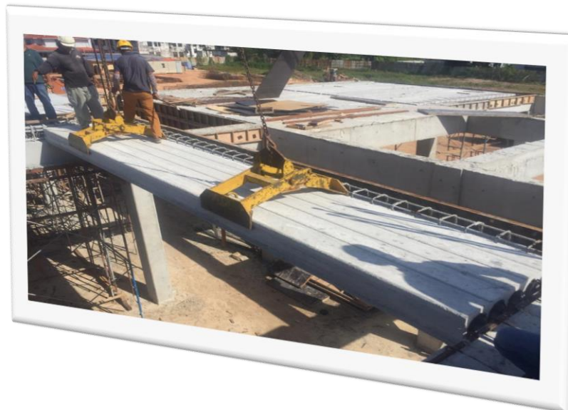
Proses pemasangan panel IBS
